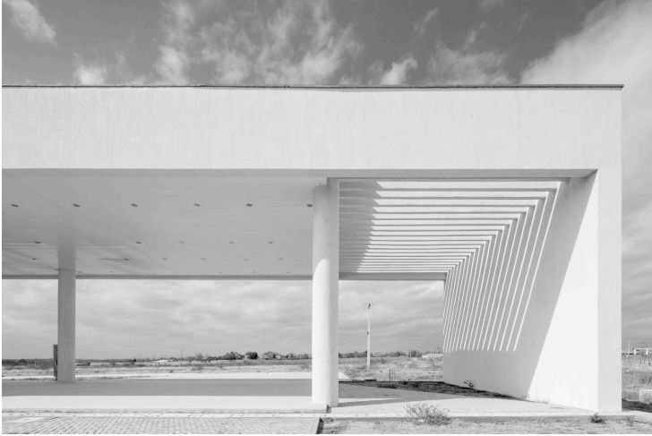
Fig. 04 – Sombra da pérgola no pórtico de entrada
