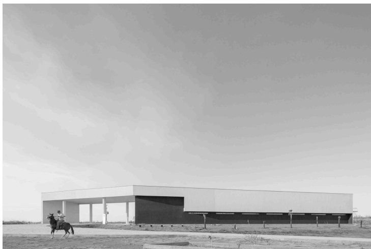
Fig. 03 – Bloco administrativo da UFC em Crateús
